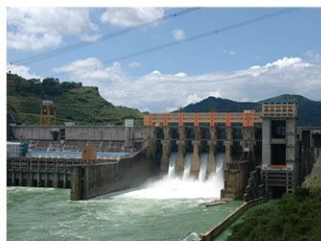
水电站综合自动化系统
