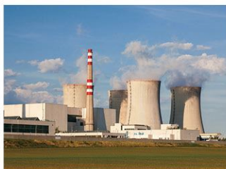
发电厂综合自动化系统
