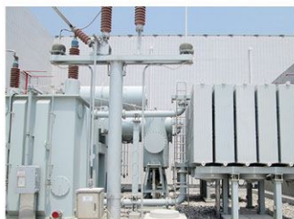
变电站综合自动化系统
